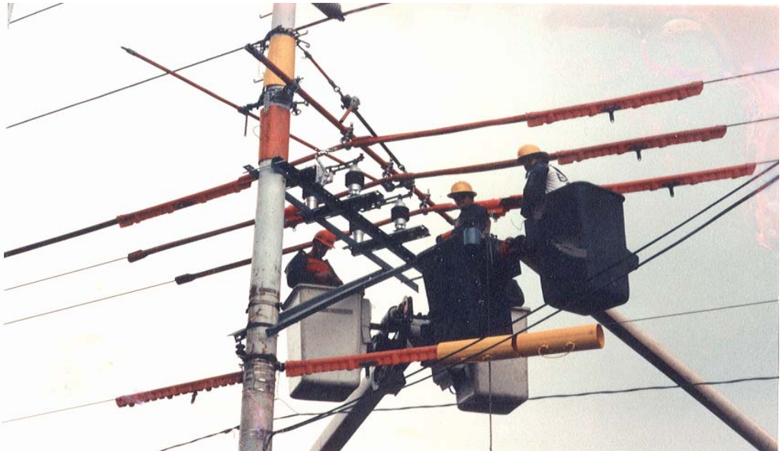
Trabajos con líneas Energizadas ( Instalación de un interruptor de 600 amperios 15 kv).
