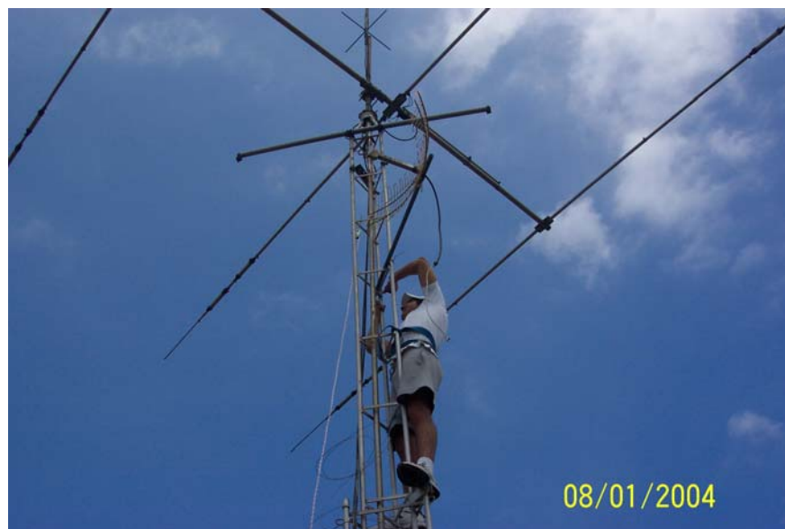
Fig. 2.33 Instalación de antena de recepción.
