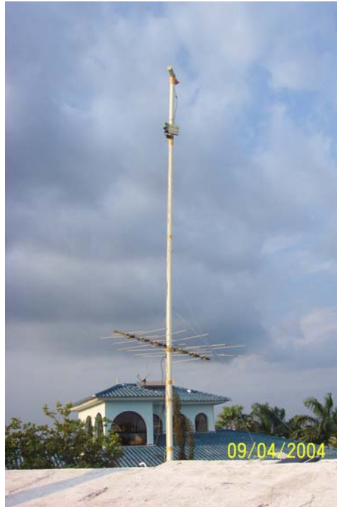
Fig. 2.34 Instalación de torre de prueba para transmisión.
