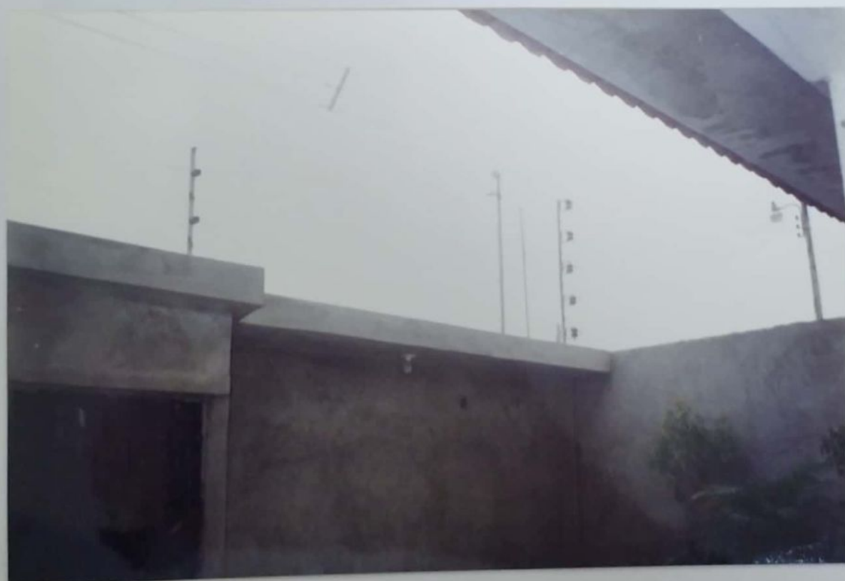
FIGURA 38.- VISTA DE LA MALLA DESDE EL INTERIOR DE LA VIVIENDA
