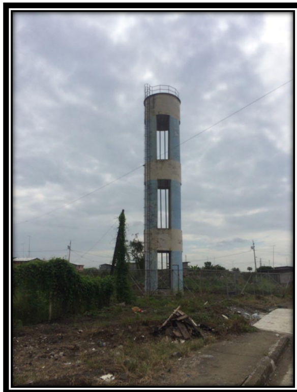
Figura 3.7 Tanque elevado para distribución al poblado.
