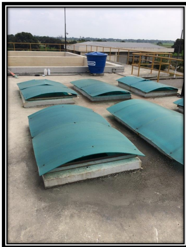
Figura 4.12 Sitio de almacenamiento de agua de salida del filtro.
