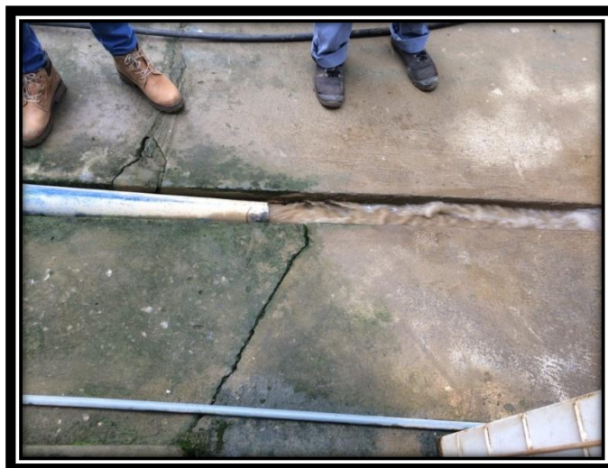
Figura 3.5 Sistema de retrolavado para el filtro.
