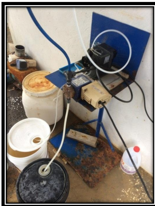
Figura 3.3 Sistema dosificador de cloro y coagulante.
