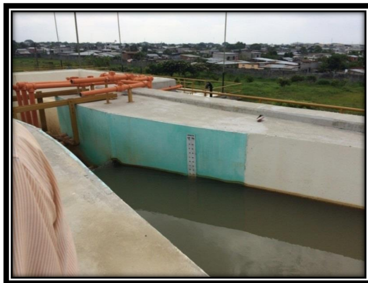
Figura 4.5 Canaleta Parshall para mezclado hidráulico del coadyuvante.
