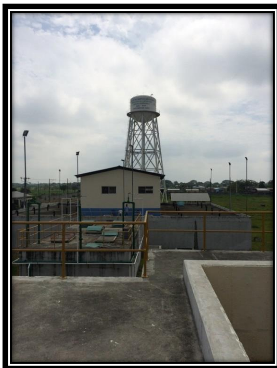
Figura 4.13 Piscinas de cloración y tanque de almacenamiento elevado. Fuente: Briones J., Macías E., 2017
