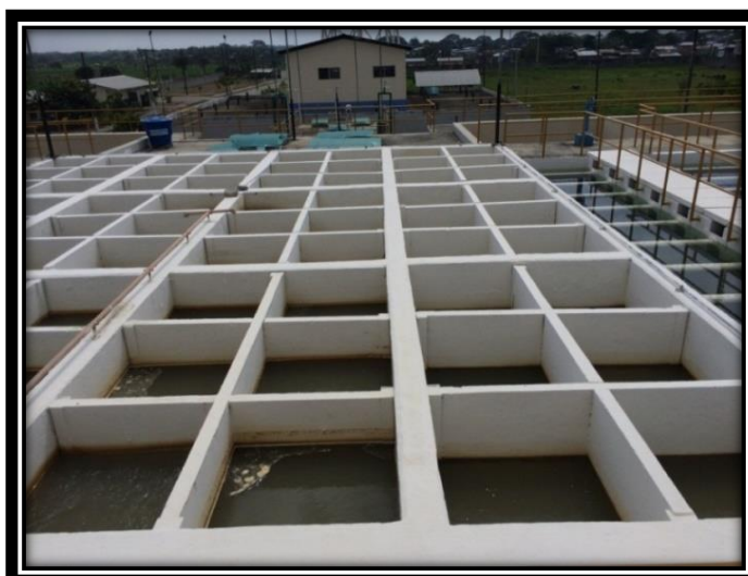
Figura 4.8 Cajones de Floculación de tres velocidades.
