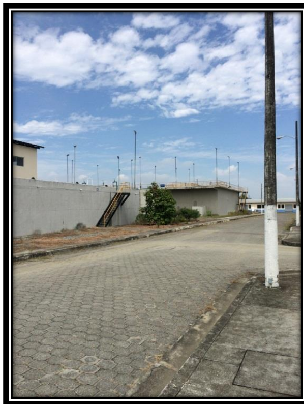
Figura 4.1 Entrada de la planta potabilizadora de agua del cantón Daule Fuente: Briones J., Macías E., 2017
