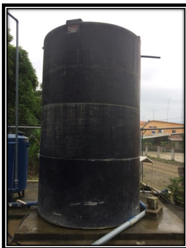
Figura 3.6 Tanque de almacenamiento de la planta potabilizadora.
