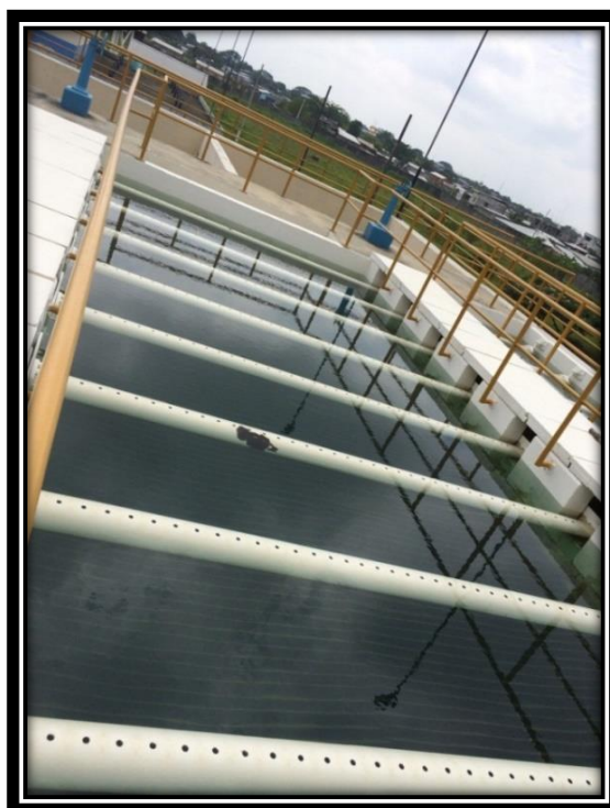
Figura 4.10 Fase de sedimentación. Fuente: Briones J., Macías E., 2017
