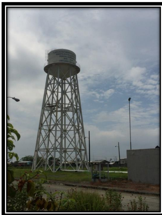
Figura 4.15 Tanque elevado para distribución por gravedad a la población de Daule.
