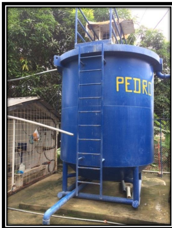
Figura 3.2 Sistema de coagulación-floculación y sedimentación.
