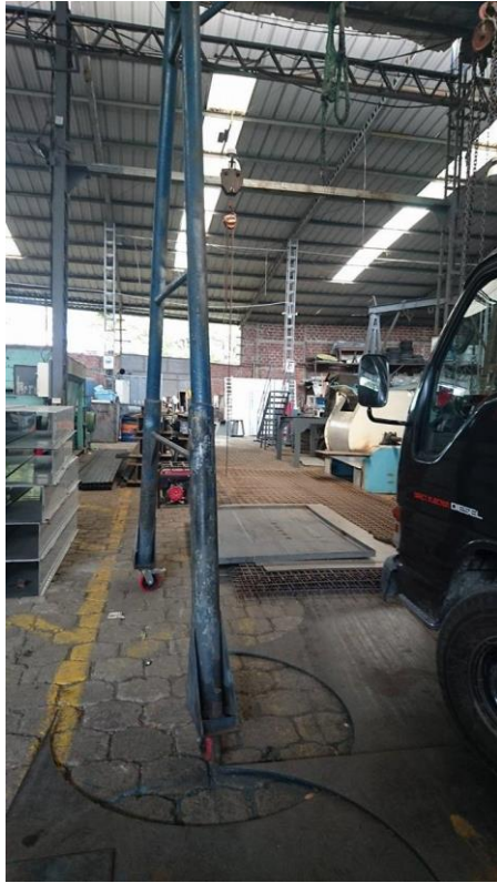
FIGURA 12 INSPECCIÓN DE OBSTÁCULOS EN EL PISO Y PISO IRREGULAR
