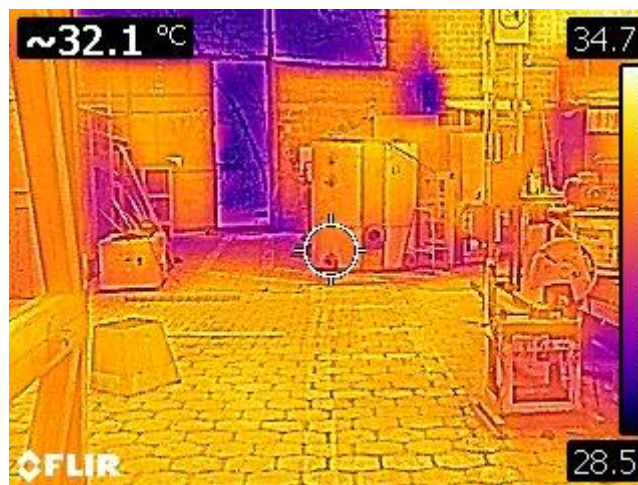
Figura 20. Fotografía termografica del área de circulación del área de soldadura.
