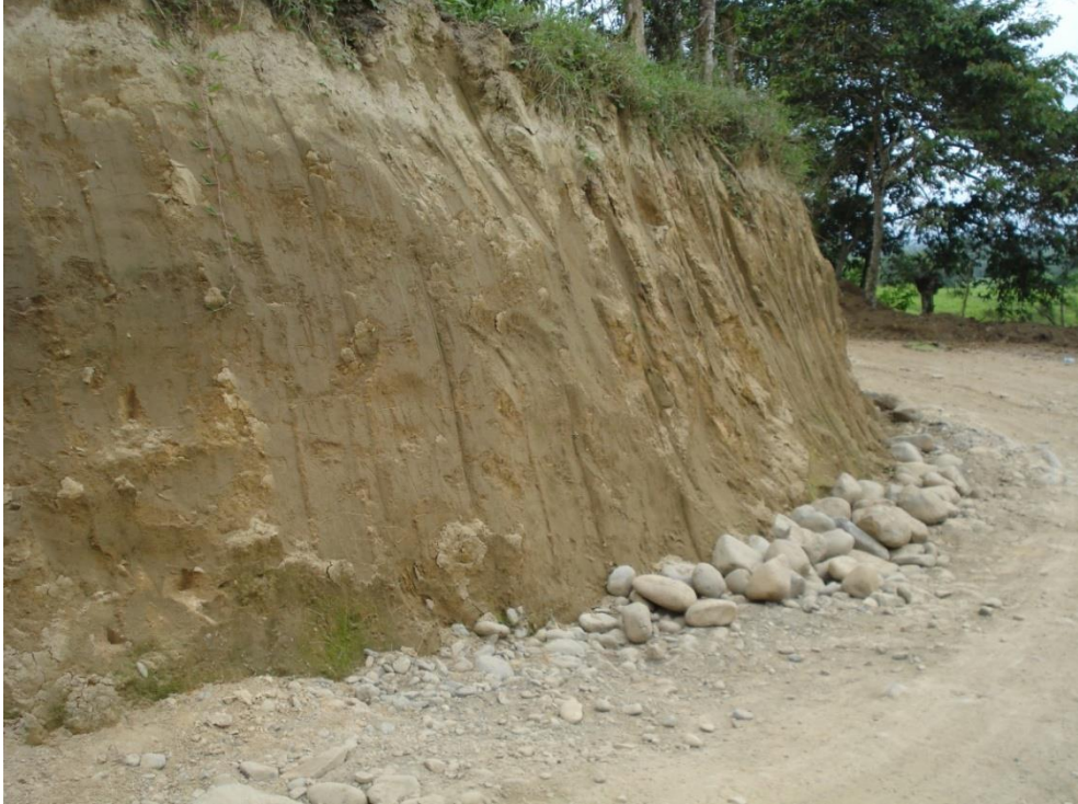
Foto 7 A continuación podemos observar una vía de acceso en la que se han realizado excavaciones en la que podemos notar que el terreno es arcilloso lo que es beneficioso para nuestro proyecto ya que ahorra mucho en lo que se debe a material utilizable para cimientos y canalización.
