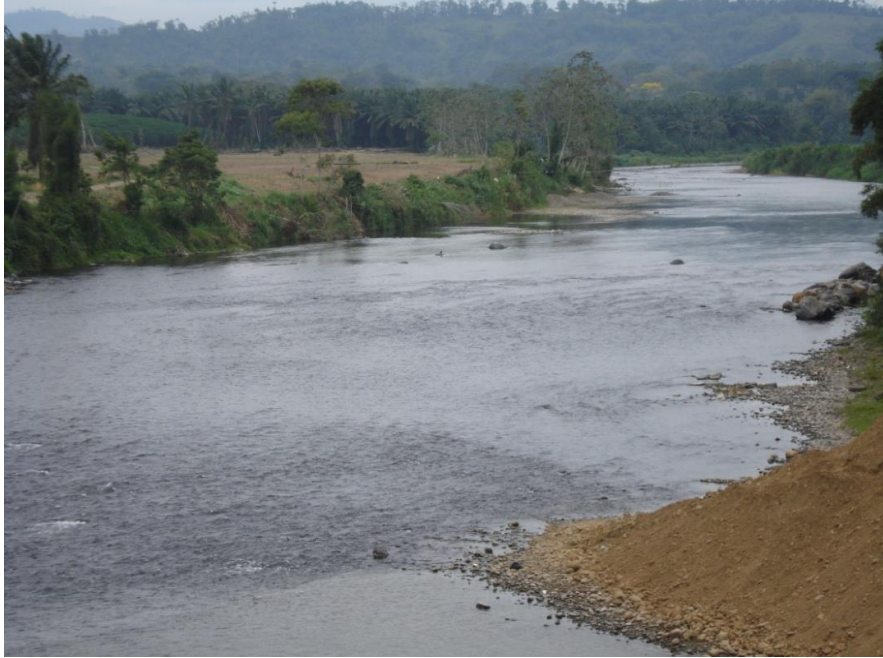
Foto 1 Rio Baba junto a población de Patricia Pilar vista aguas abajo. A la derecha podemos observar material arcilloso como base de un nuevo puente en construcción.
