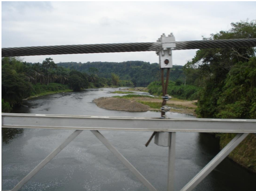
Foto 2 Rio Baba vista aguas arriba en el que se observa parte de la estructura del puente colgante sobre el en la actualidad.
