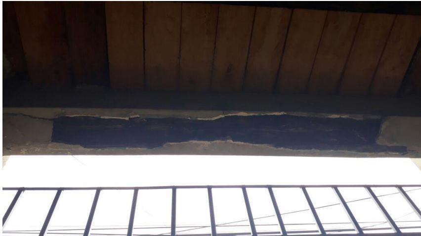
**Figura 1.2** Daño en una viga principal de la vivienda.
