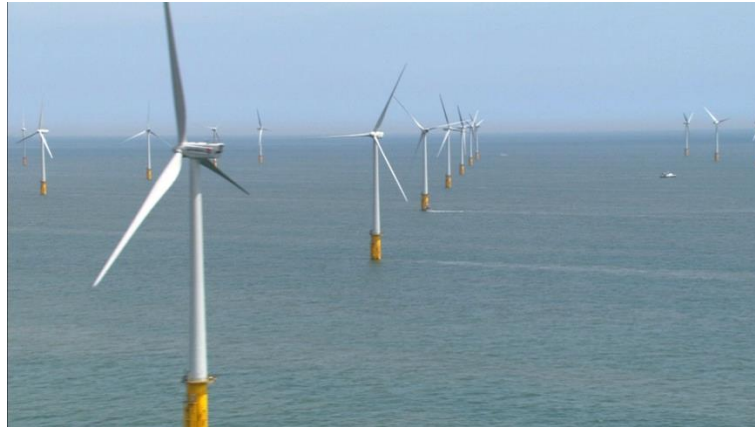
Figura 1.4 Thanet offshore, mayor parque eólico marino.
