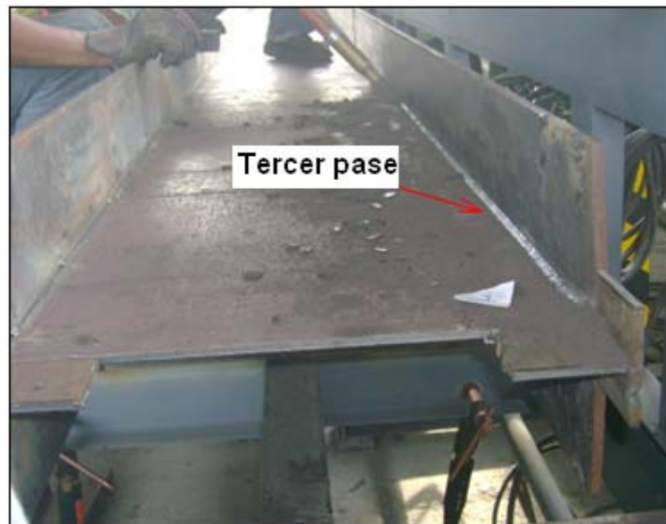
FIGURA 4.40: SOLDADURA DEL TERCER CORDÓN CON SAW.
