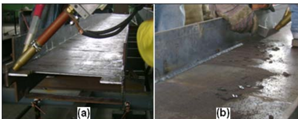
FIGURA 4.34: SOLDADURA DEL PRIMER CORDÓN CON SAW.
