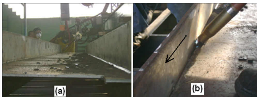
FIGURA 4.42: SOLDADURA DEL CUARTO CORDÓN CON SAW.
