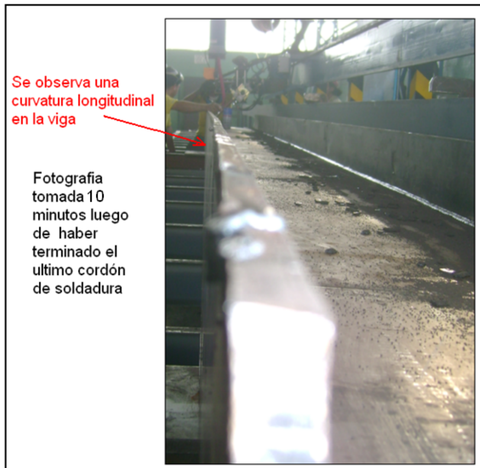
FIGURA 4.44: CURVATURA EN LA VIGA I
