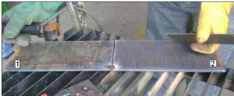
FIGURA 4.19: PREPARACIÓN DE LAS PLANCHAS.
