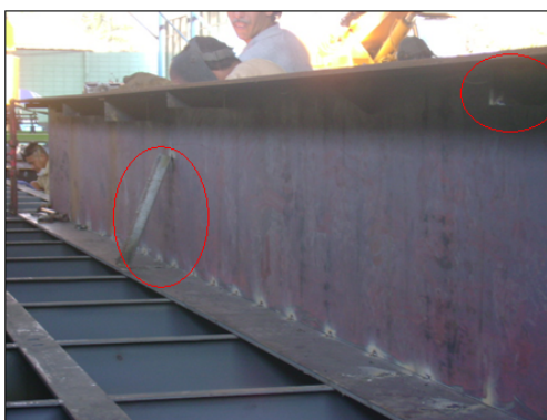
FIGURA 4.30: EXTRACCIÓN DE LOS SOPORTES DE LAS ALAS
