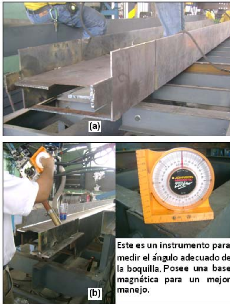
FIGURA 4.31: ALINEACIÓN DE LA VIGA EN LA MAQUINA
