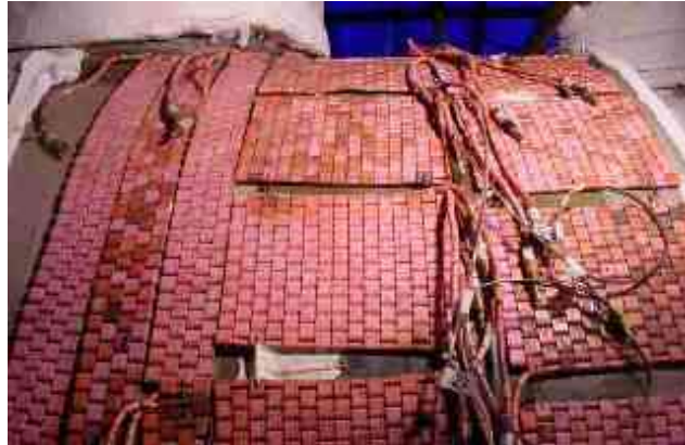
FIGURA 2.20: TRATAMIENTO TÉRMICO A UN TANQUE CILÍNDRICO
