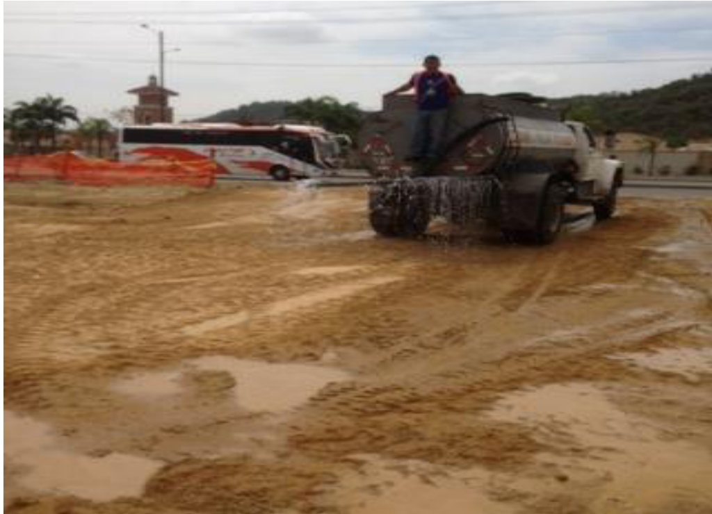
FIGURA 35: CONTROL DE POLVO CON TANQUEROS.
