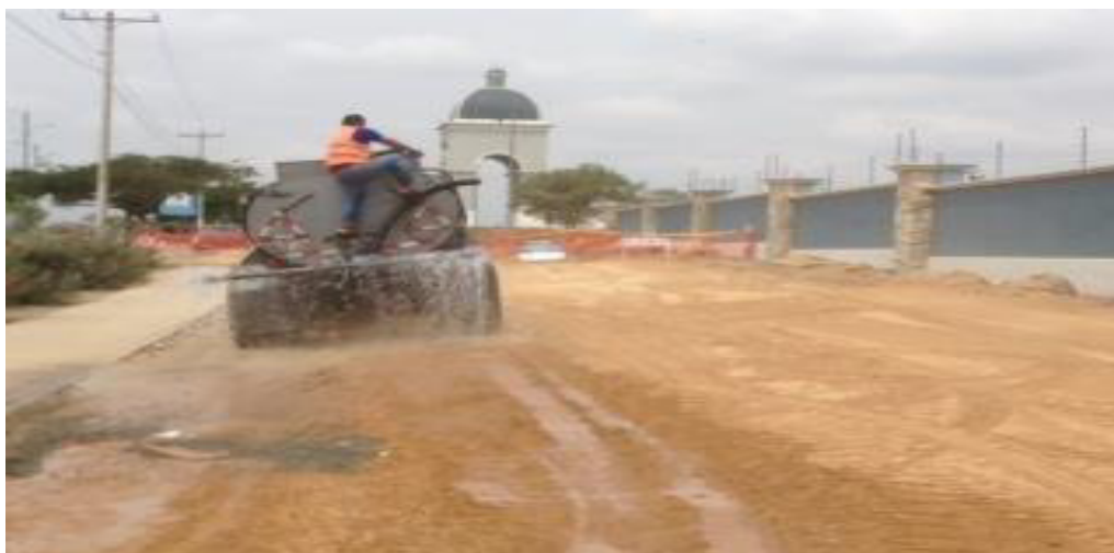
FIGURA 34: CONTROL DE POLVO CON TANQUEROS.
