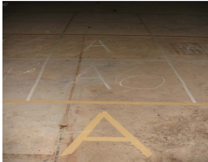
FIGURA 4.1 SEÑALIZACIÓN DE LOS BLOQUES
