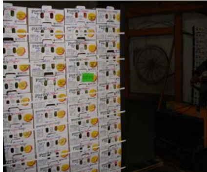
FIGURA 2.22 TÚNEL DE FRÍO
