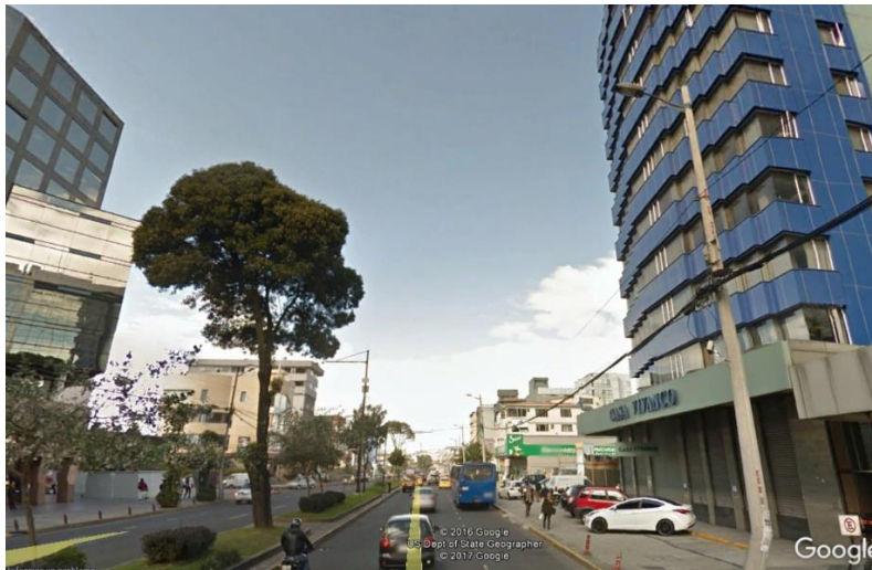
Ilustración 19 Instalaciones edificio de La Constructora Quito
