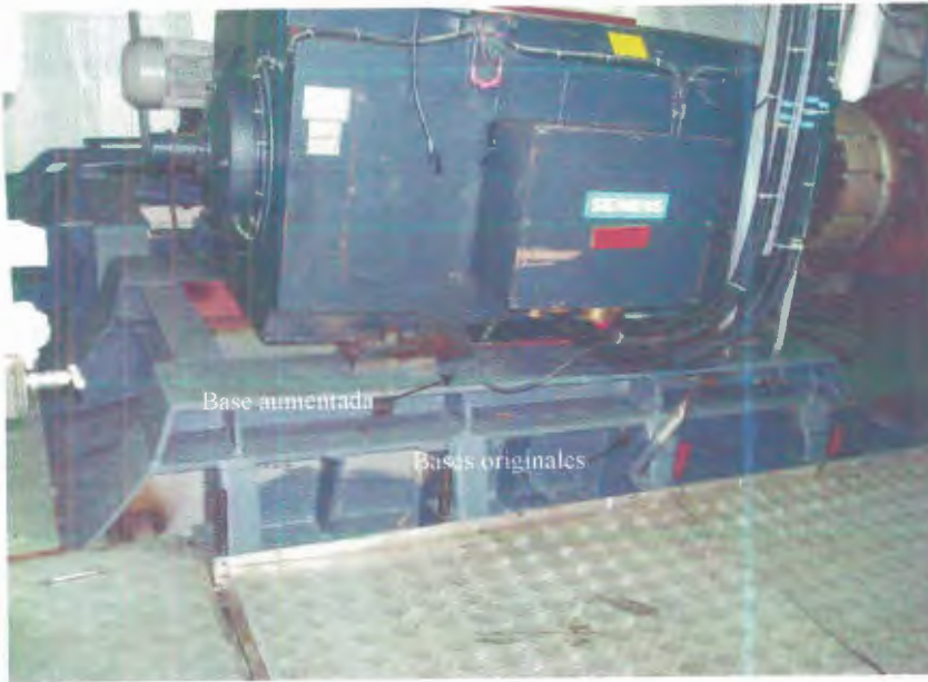
Foto 10.- Instalación de moto propulsores
