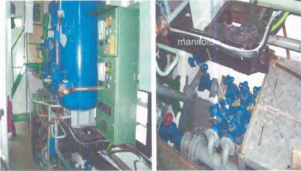
FOTOS 22 y 23.-Tanques de presión y manifold del sistema de agua dulce.
