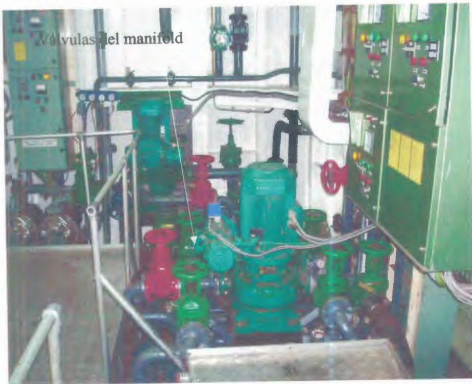
FOTO 21.- Montaje de bombas en sala de máquinas.
