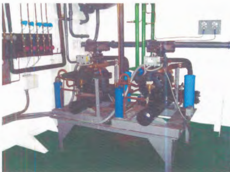
FOTO 32.- Plantas frigoríficas instaladas en la embarcación.
