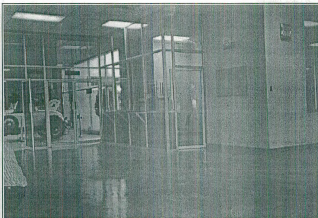
FOTO # 4: Piso de marmettone y aumento de divisiones de aluminio y vidrio en zona de Biblioteca en planta baja
