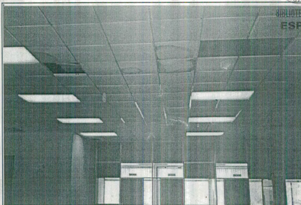
FOTO # 2: Vista de tumbado falso - pandeo y manchas en paneles - en zona de primer piso.
