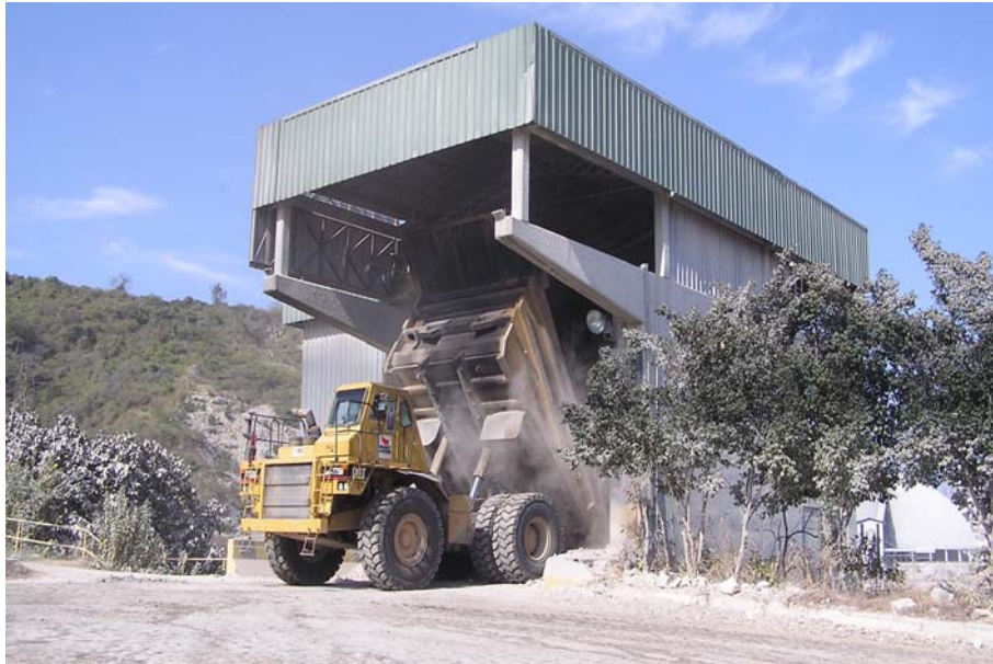
FIGURA 1.3 DESCARGA DE LA CALIZA EN LA TRITURADORA
