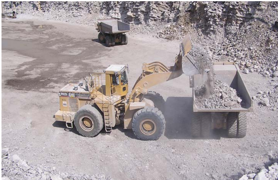
FIGURA 1.2 CARGA Y ACARREO DE LA CALIZA HACIA LA TRITURADORA
