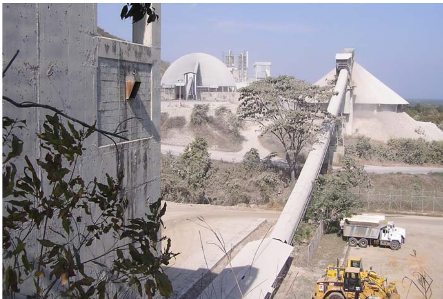
FIGURA 1.4 ALMACENAMIENTO Y/O TRANSPORTE DE LA CALIZA HACIA LA FÁBRICA DE CEMENTO.
