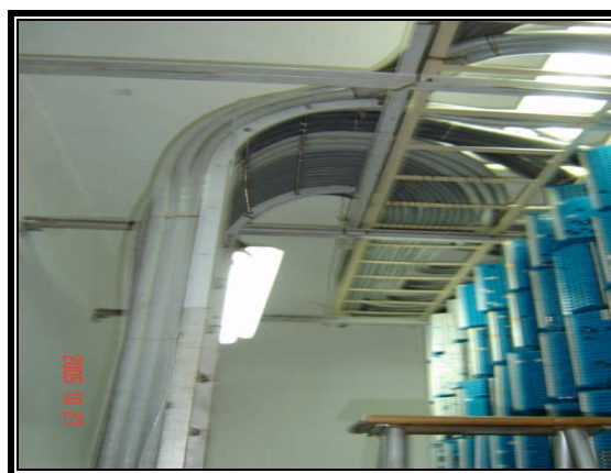
Figura 3.8 Canalizado de los cables hacia el switch de voz
