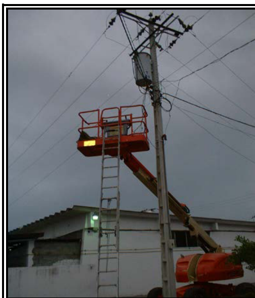
FIG 3.10 Fotografía Medición en Sección HOSNAV
