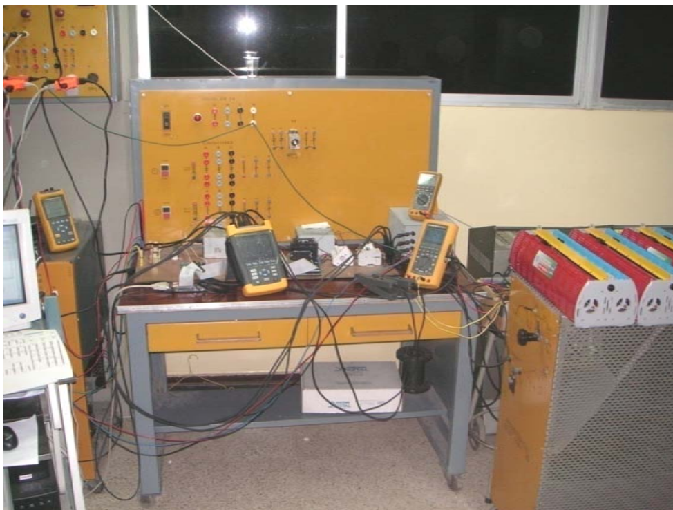
Foto K.11 Sistema completo operando en modo normal
