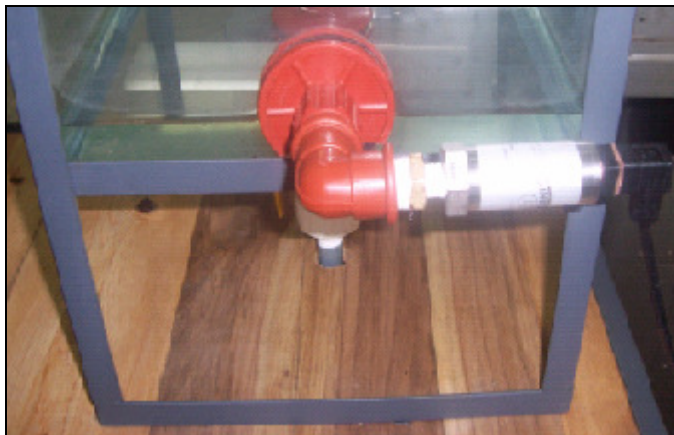
FIGURA 2.15 CONEXIÓN DE TRANSMISOR DE PRESIÓN AL TANQUE.
