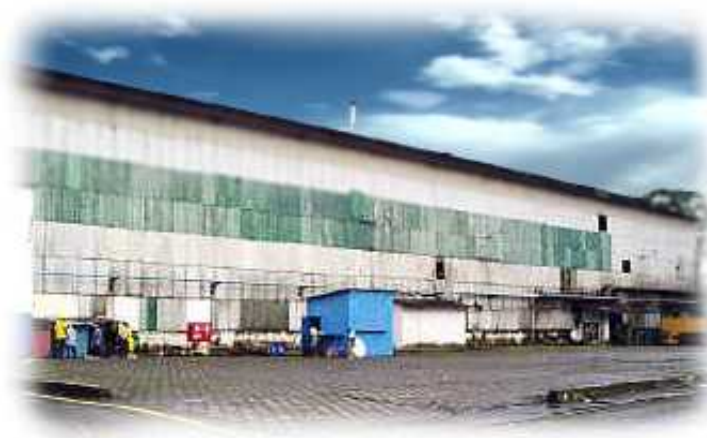
Fig 1.8 – Vista externa de la planta.
