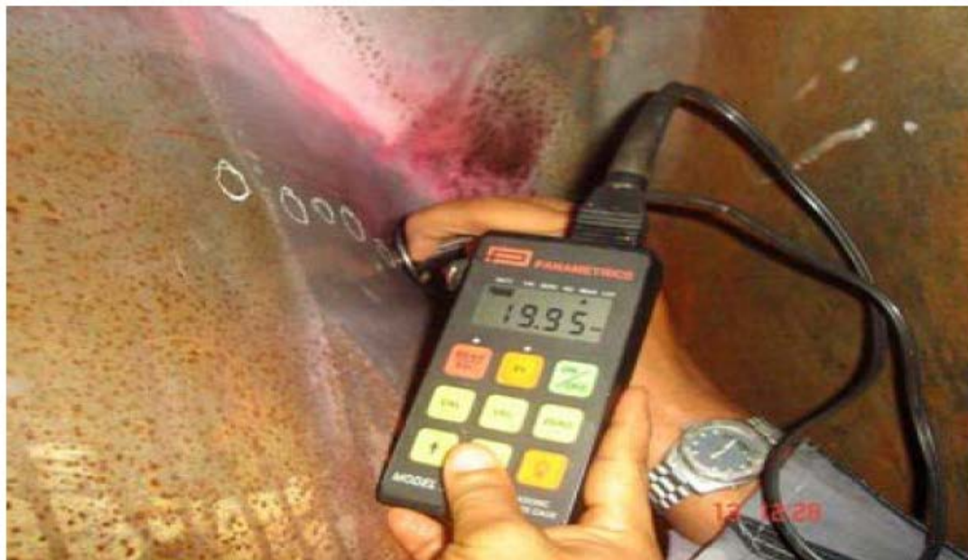
Figura 3.9 Inspección del equipo mediante ultrasonido
