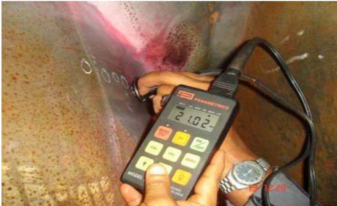
Figura 3.10 Inspección del equipo mediante ultrasonido
