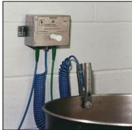
Fig. 2.12 Sistema de monitoreo local y remoto Sistema de Monitoreo Remoto con Pinza GAT-IP
