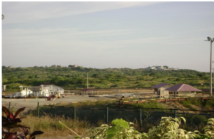
Fig. 2.6 Tanques salchichas a la izq. y, cuarto de control a la derecha.
