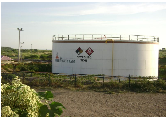
Fig. 2.7 Tanque de almacenamiento secundario (TK N)
