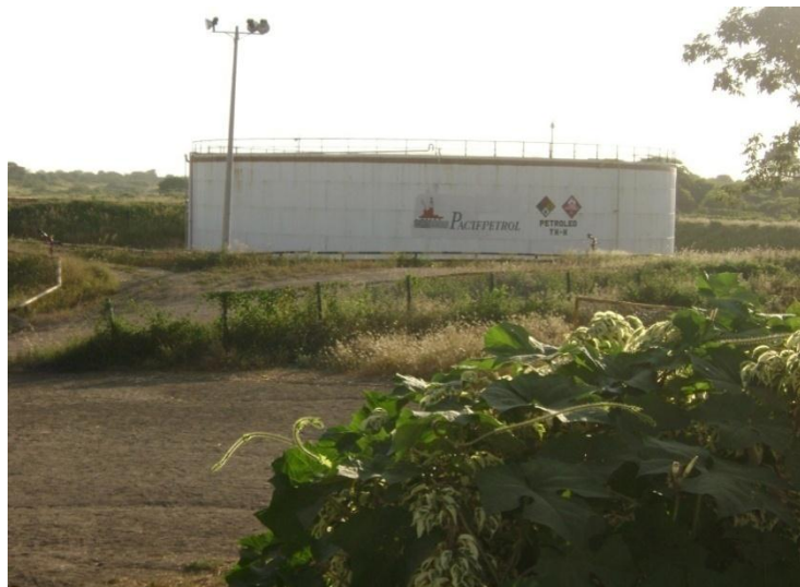
Fig. 2.8 Tanque primario o final (TK K)
