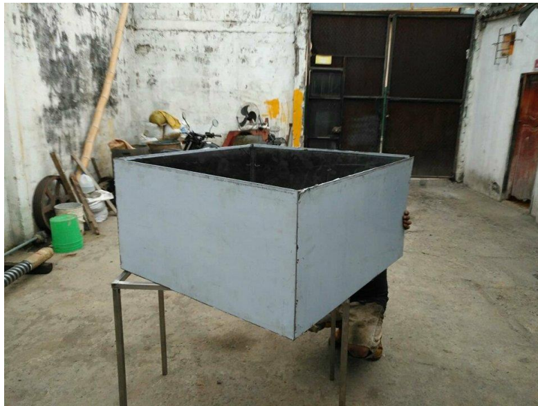
Figura 2. 11: Construcción de la carcasa del equipo
