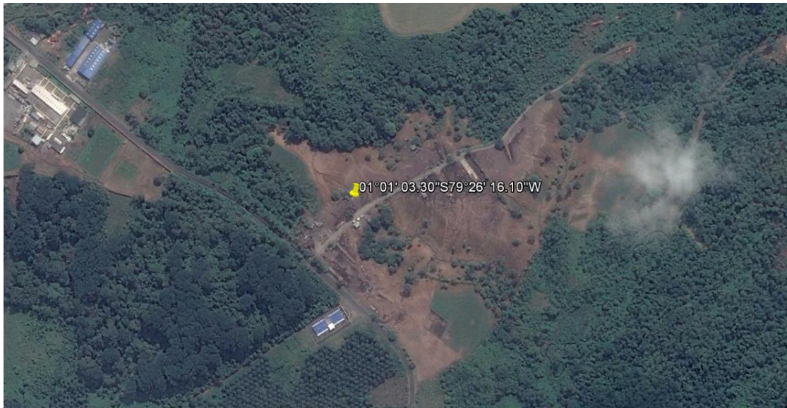
Figura 1.3: Estación Repetidora Ubicada en Quevedo
