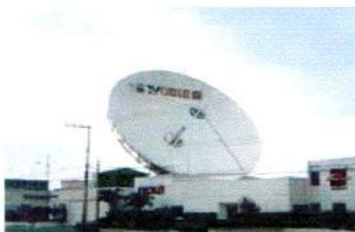
FIGURA 4.3. Vista de antena parabolica para recepcion de la señal satelital de la red de tv cable
