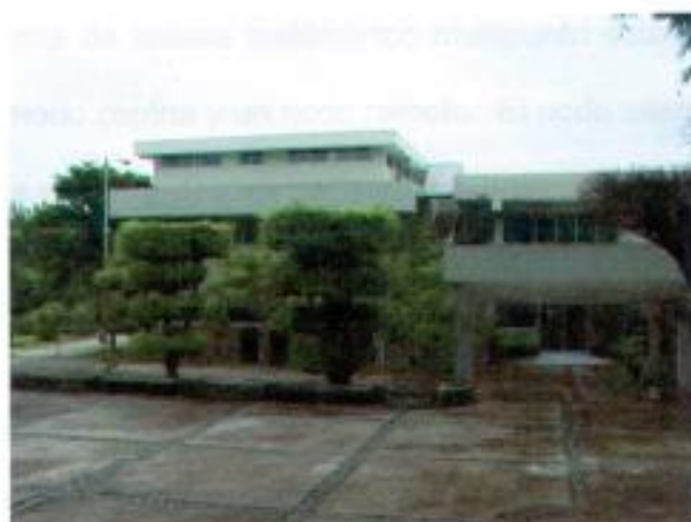
Gráfico 3-7 Edificio 37 en el área de tecnologías
