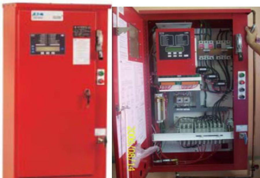
**FIGURA 3.12 TABLERO DE CONTROL DE MOTOR ELÉCTRICO**
