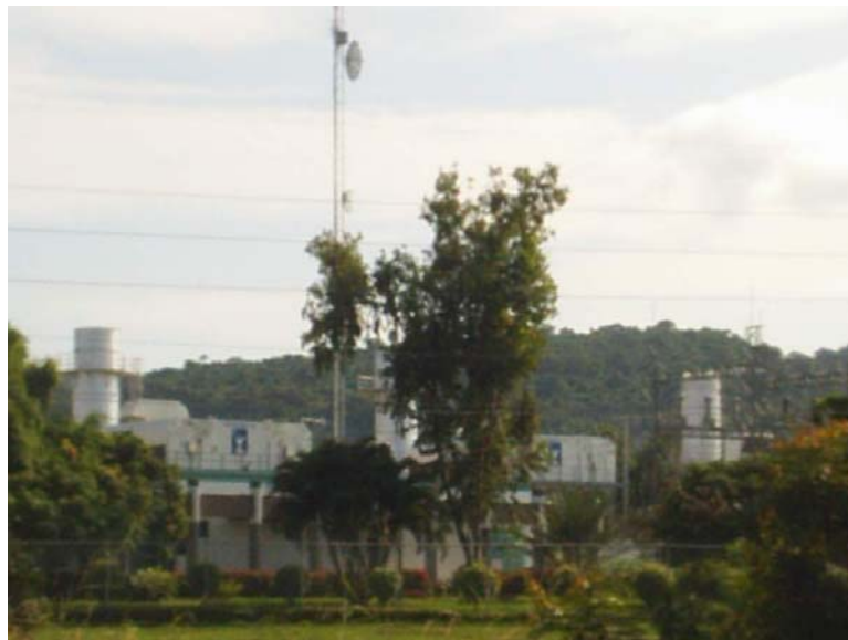
VISTA DE LA CENTRAL TERMICA ELECTROQUIL S.A.
