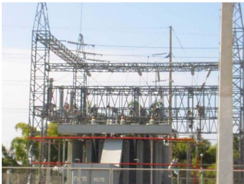
FIGURA 1.7 SUBESTACION 138KV
