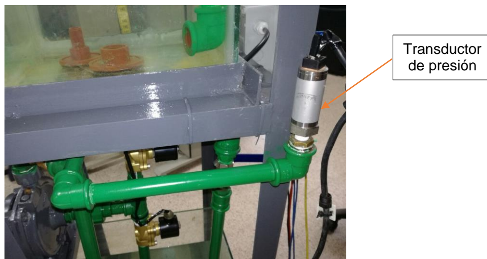
Figura 4.3: Instalación del transductor de presión
