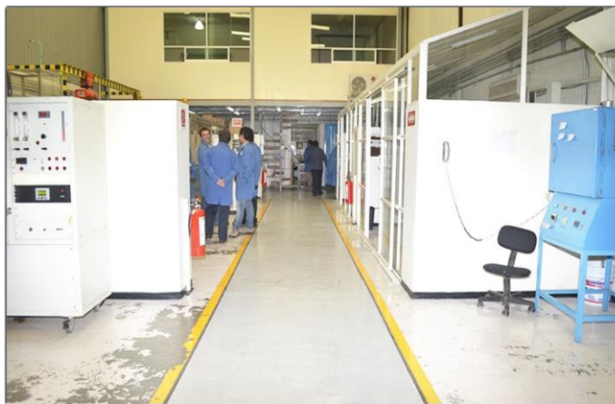
Figura 1.1 Laboratorio de pruebas eléctricas LabIntec
