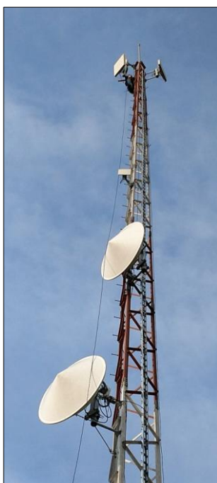
Figura 1.5: Nodo de comunicaciones con los 3 transmisores usados.
