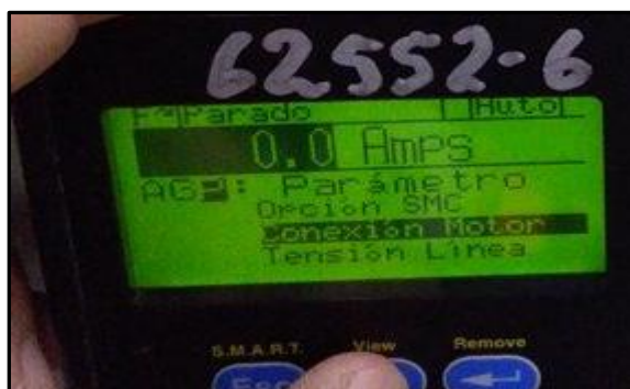
Figura 3. 23. HMI Conexión del motor
