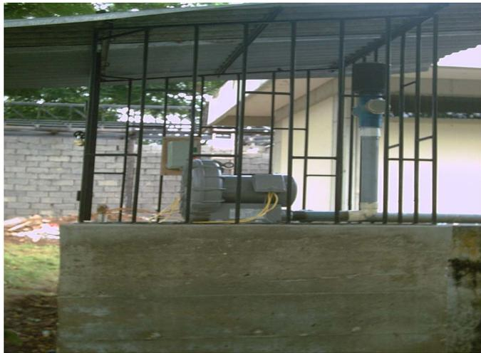
Fig. 10. Blower nuevo con arrancador eléctrico y caseta de protección y seguridad
