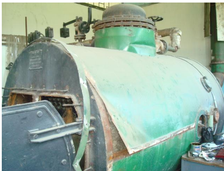
Fig. 1.6 Caldero dañado
