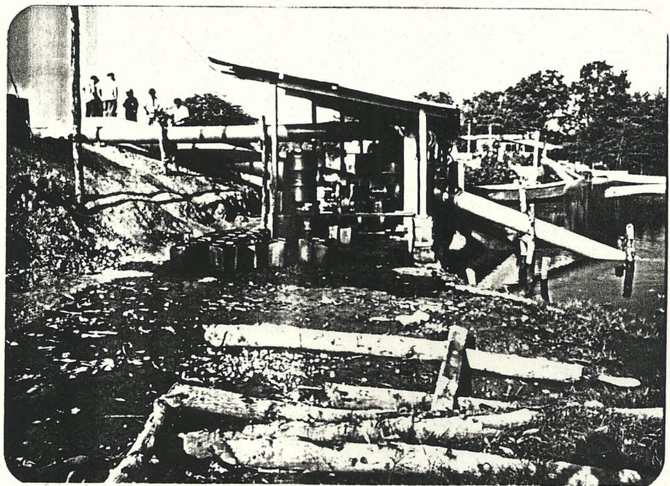
Fig. 5 ALMACENAMIENTO DE COMBUSTIBLE MEDIANTE POMAS DE CINCO GALONES
