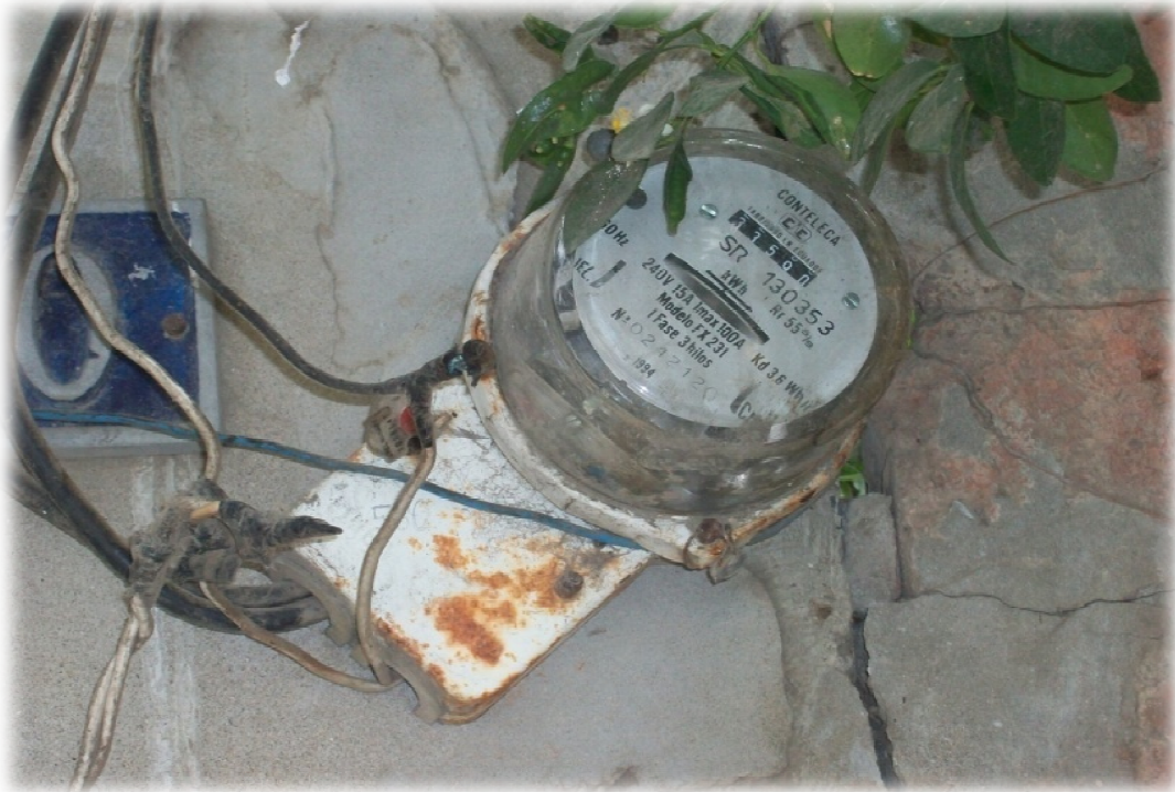
FOTO # 2 DERIVACIÓN EN LA ACOMETIDA
