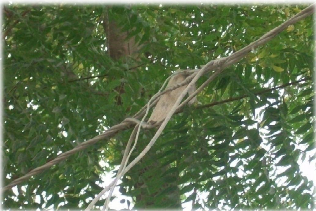
FOTO # 2 DERIVACIÓN EN LA ACOMETIDA
