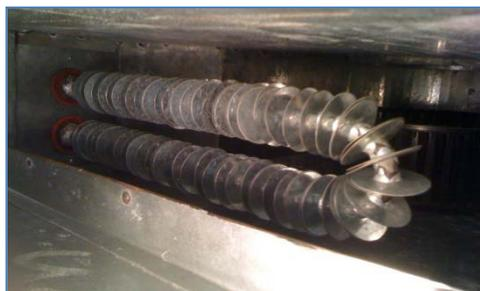
**Figura 3.17:** Resistencia de calefacción.
