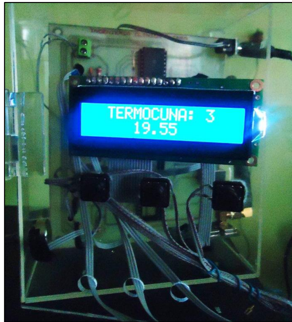
FIGURA 4.1 Central de monitoreo vista frontal
