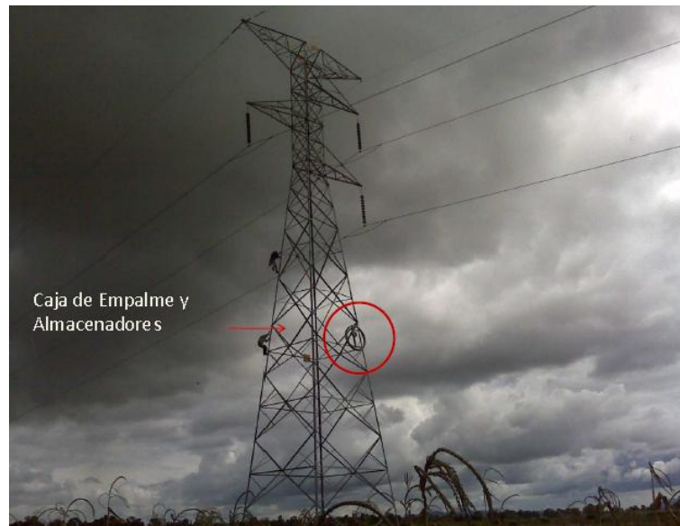
Figura 2.8.- Tendido de fibra óptica ADSS
