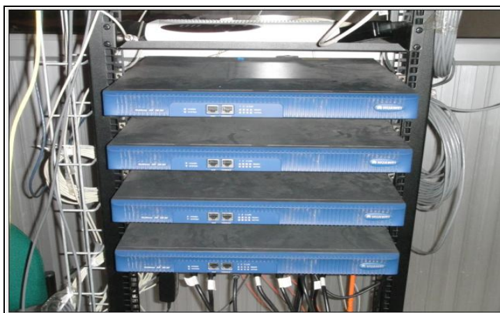
Figura 2.5.- Router Quidway AR 2830 [9]
