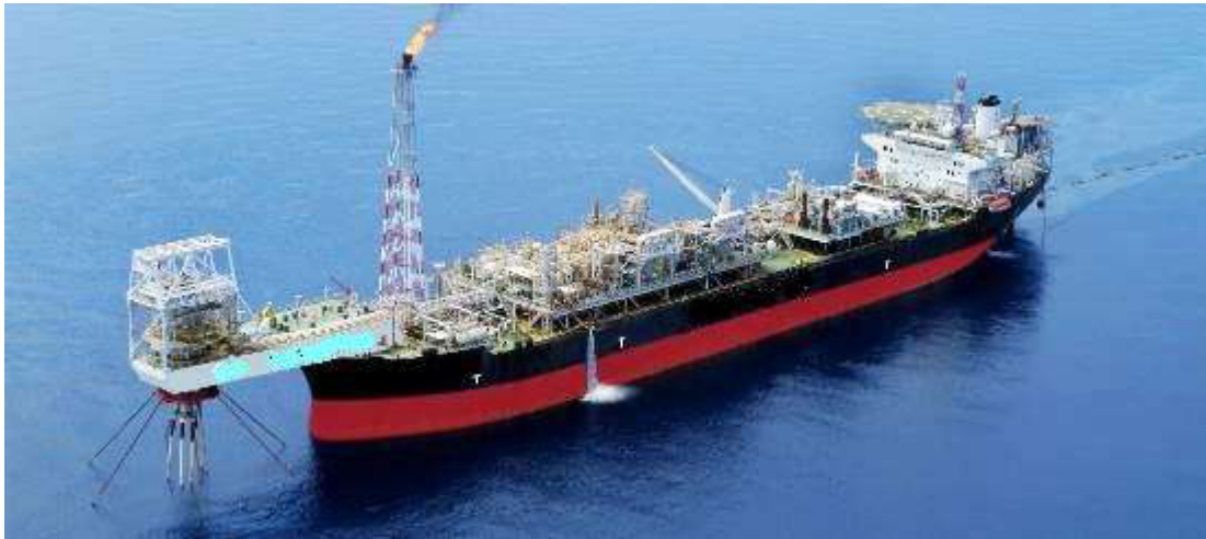
Ilustración 4. Instalación Flotante de Producción y Almacenamiento (Fuente: google images).
