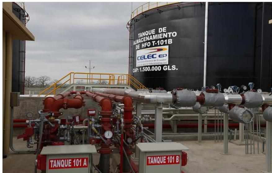
**Figura 1.10** Tanque de almacenamiento FUEL OIL 6
