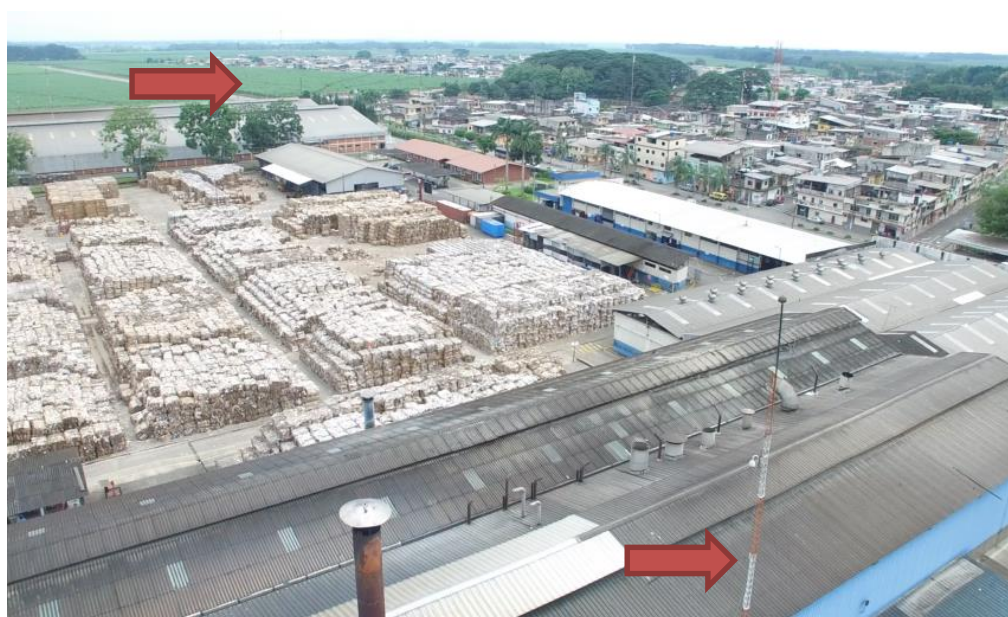
Figura 3.18: Vista aérea del enlace Panasa – Bomba 2.
