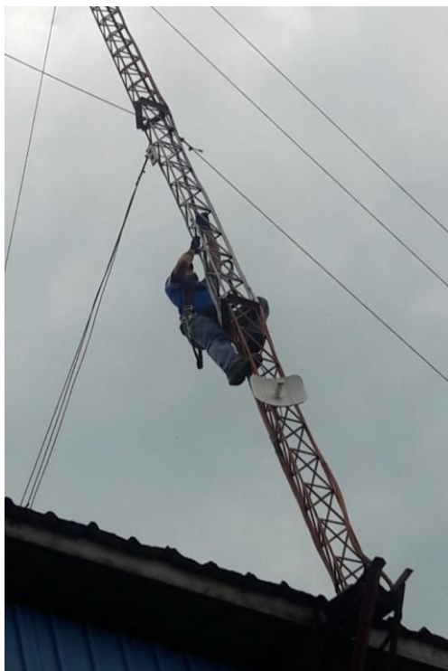
Figura B.3: Alineación de antenas con línea de vista
