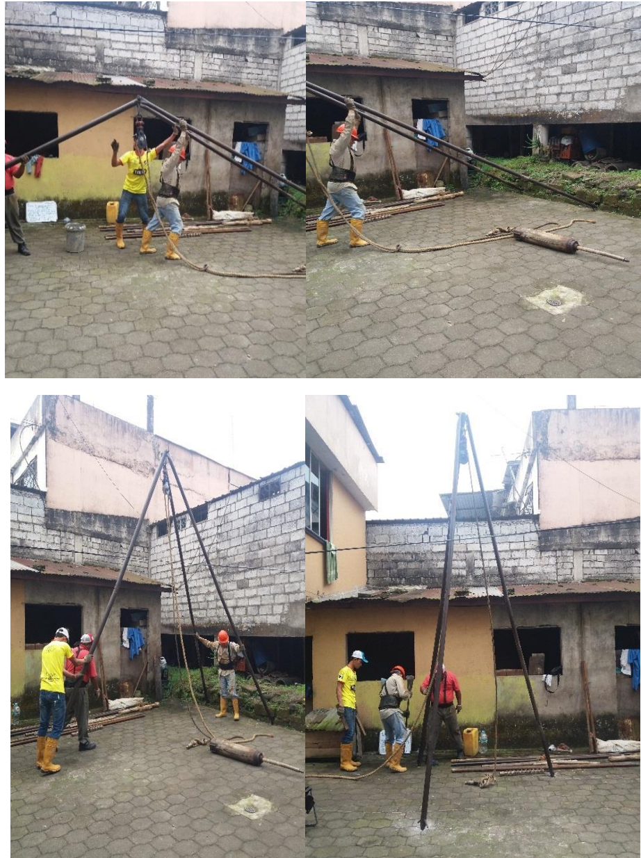
Figura 3.2 Ensamble del equipo SPT Fuente: Almache, I., Sánchez, R., 2017
