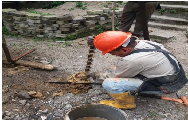
Figura 3.4 Limpieza de la perforación. Fuente: Almache, I., Sánchez, R.,2017
