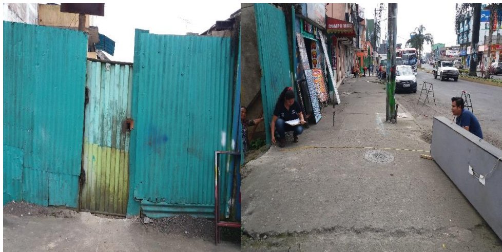
Figura 2.8 Medición de bordillos del terreno de construcción. Fuente: Almache, I., Sánchez, R.,2017
