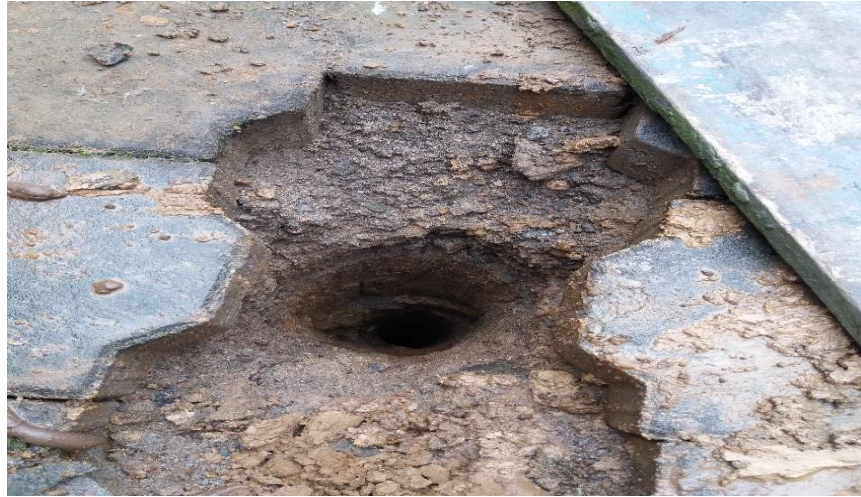
Figura 3.19 Orificio del primer sondeo. Fuente: Almache, I., Sánchez, R.,2017
