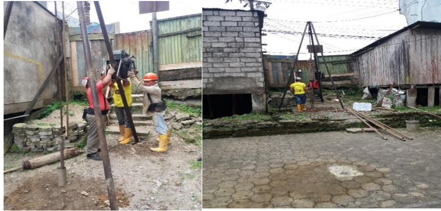
Figura 3.21 SPT sondeo # 2. Fuente: Almache, I., Sánchez, R.,2017
