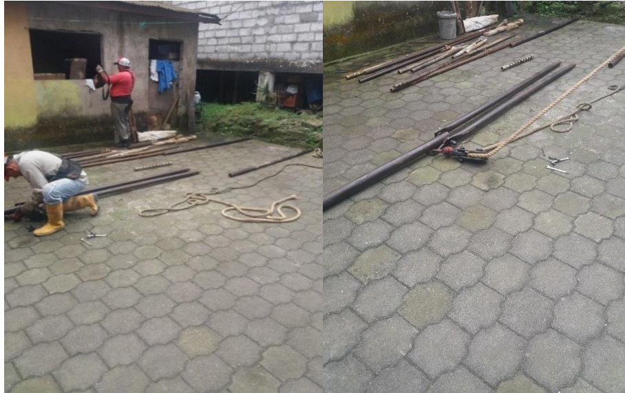
Figura 3.5 Equipos para ensayo SPT. Fuente: Almache, I., Sánchez, R.,2017
