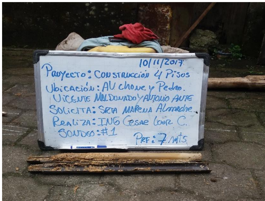
Figura 3.12 Muestra a 7 metros de profundidad. Fuente: Almaché, I., Sánchez, R., 2017
