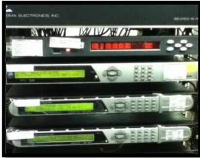
*Figura 4.5 Receptor satelital monocanal*
