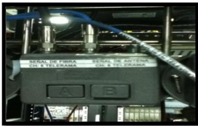
*Figura 4.16. Splitter de canal local*
