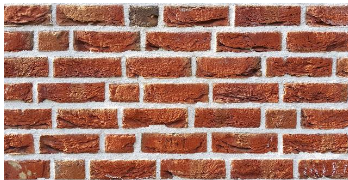
Figura 6. 3 Muro de ladrillos
