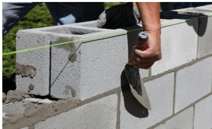
Figura 6. 4 Construcción de muro con bloque
