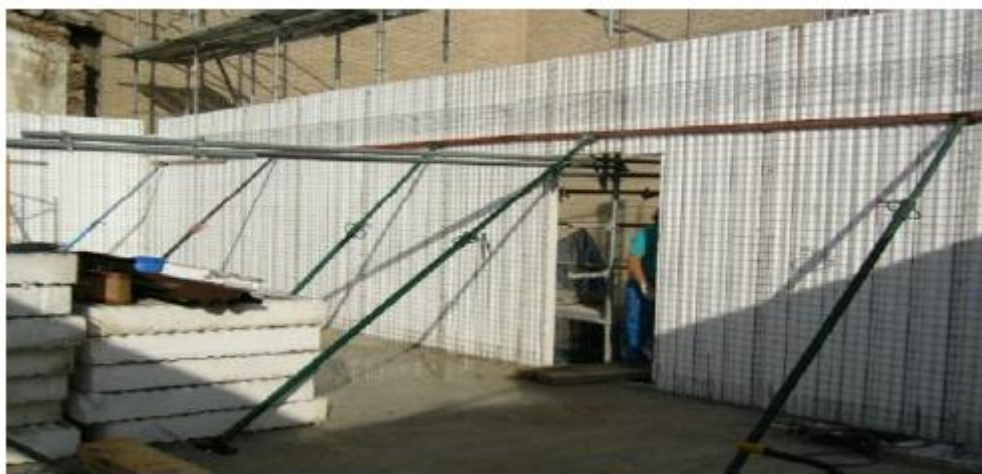
Figura 4.7 paneles de hormi2 Fuente: Maltez, 2009
