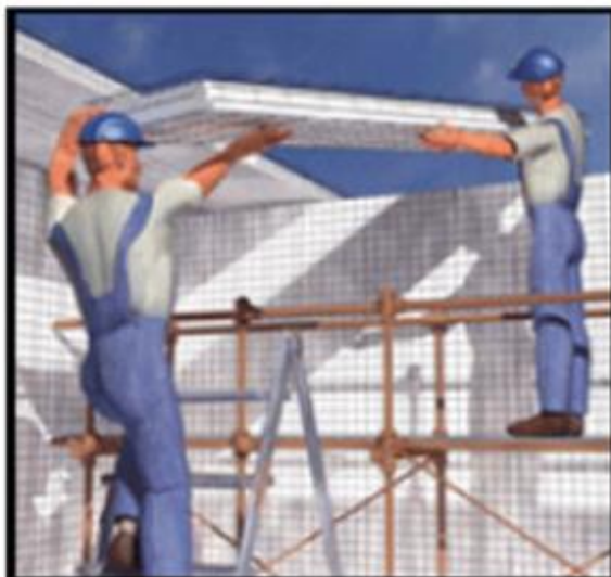
Figura 4.8 Colocación de paneles para la losa Fuente: Maltez, 2009
