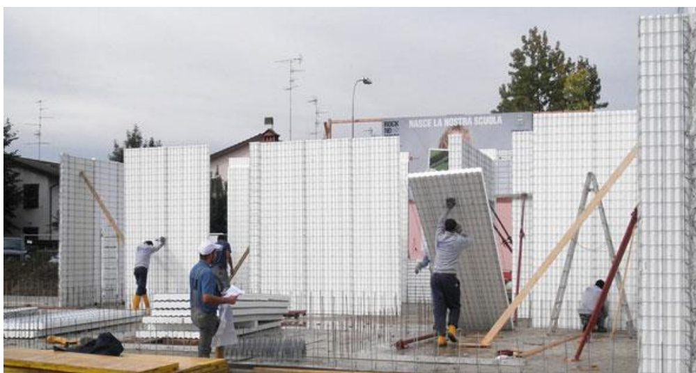
Figura 4.6 Armado de muro completo Fuente: Maltez, 2009
