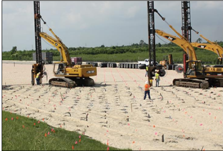
Figura 6.3. Colocación de Wick Drains. Fuente: Geosynthetica, 2016
