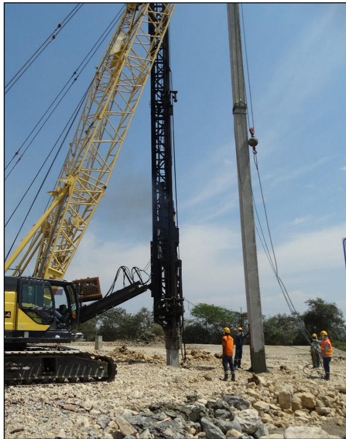
Figura 6.7. Hincado de Pilotes. Fuente: Cordero, M., Torr , M. 2017
