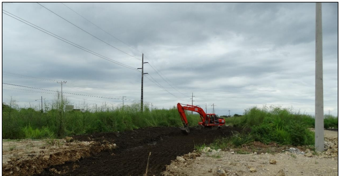
Figura 6.2. Reemplazo de material en la PTAR Las Esclusas. Fuente: Cordero, M., Torr , M. 2017
