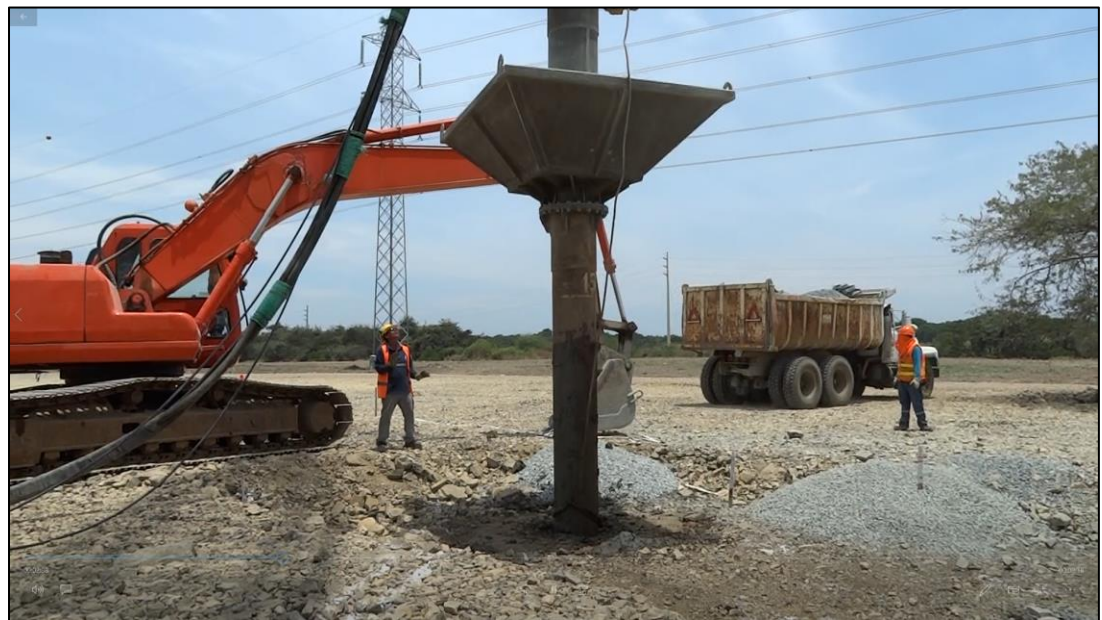
Figura 6.1. Prueba de columnas de grava en la PTAR Las Esclusas. Fuente: Cordero, M., Torr , M. 2017
