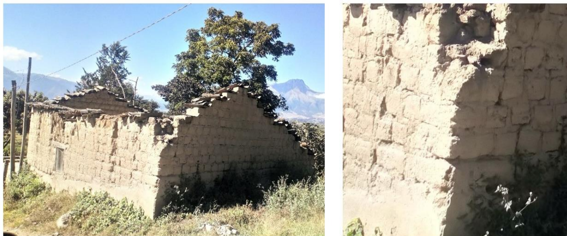
Ilustración 1.10: Construcción de adobes. Foto tomada en el sector Las Marías, en el año 2018 -antigua hacienda San José-
