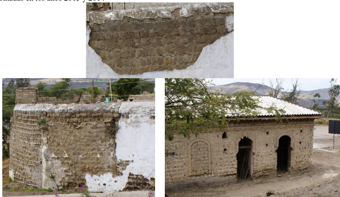
Ilustración 1.12: Muros y edificio de bloque de cangahua, ex hacienda e ingenio San José - Campus Yachay tomadas en los años 2013 y 2014
