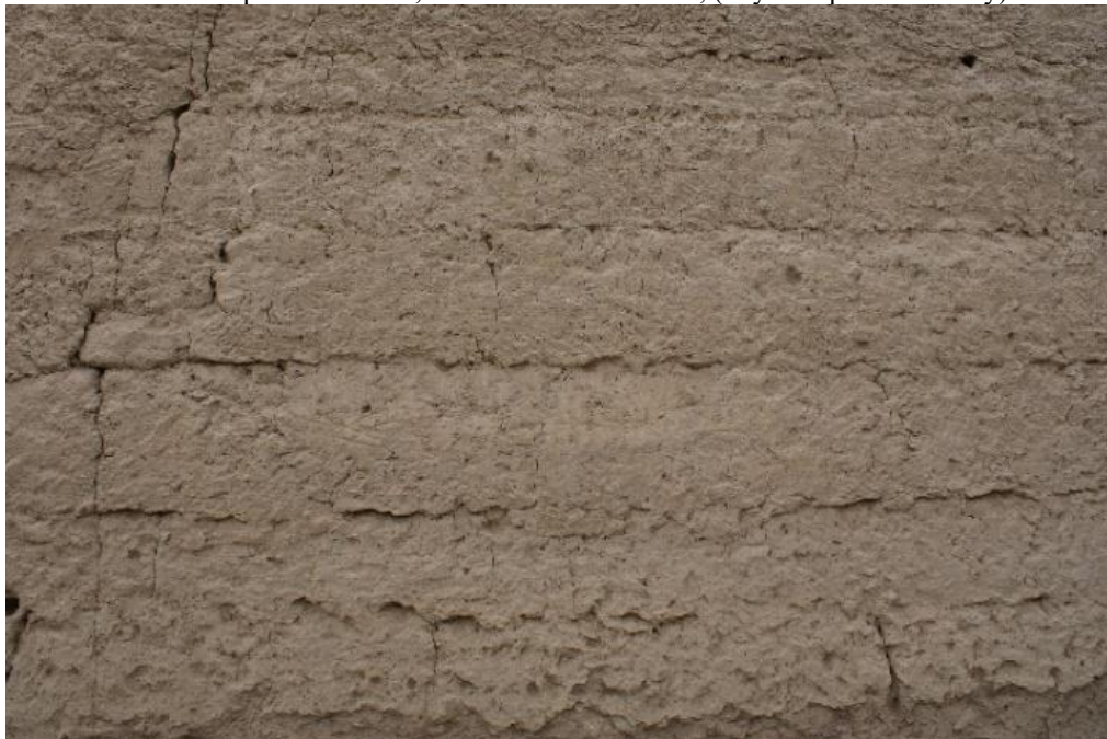
Ilustración 1.16: Detalle de pared de mano, en el Barrio El Rosario, (hoy Campus de Yachay).
