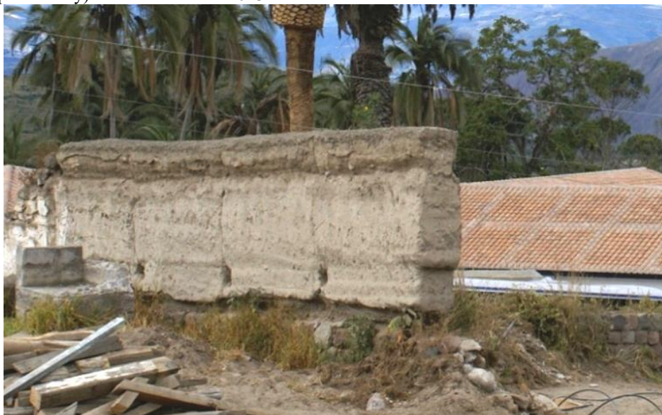
Ilustración 1.5: Fotografía de tapial barro El Rosario de la antigua Hacienda San José del cantón Urcuquí, (hoy Campus Yachay) tomada en el año 2013
