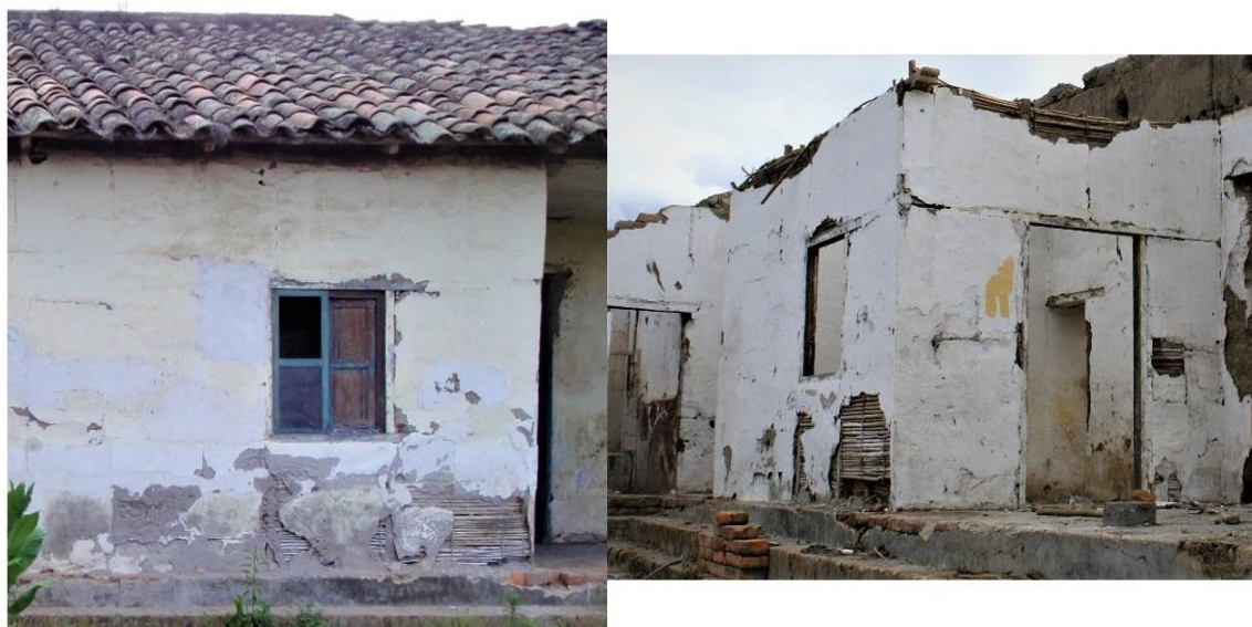
Ilustración 1.6: Fotografías de construcción en Bahareque, en el Barrio El Rosario de la antigua Hacienda San José del cantón Urcuquí (hoy Campus Yachay).
