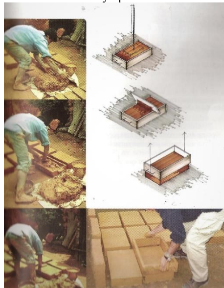
Ilustración 1.8: Infografía de elaboración de adobes y apisonado de barro en moldes
