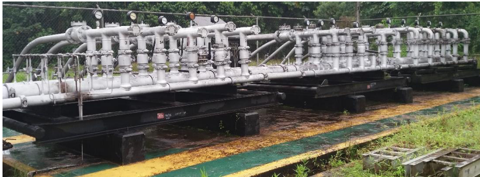
Figura 1.6 múltiple de recolección ( manifold )
