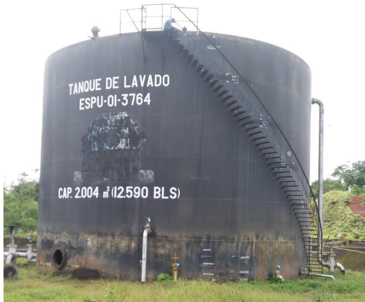
Figura 1.10 Tanque de lavado en reparación Fuente: (Choca-Quisnancela, 2018)
