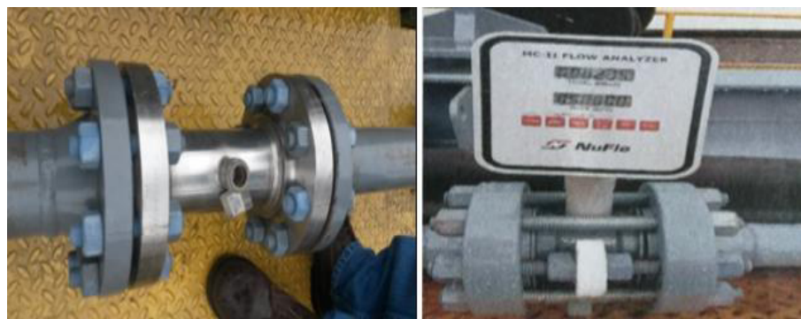
Figura 1.31 Medidor de turbina (Izq.) Analizador MCII, acoplado a la turbina Fuente: (Choca-Quinancela, 2018)
