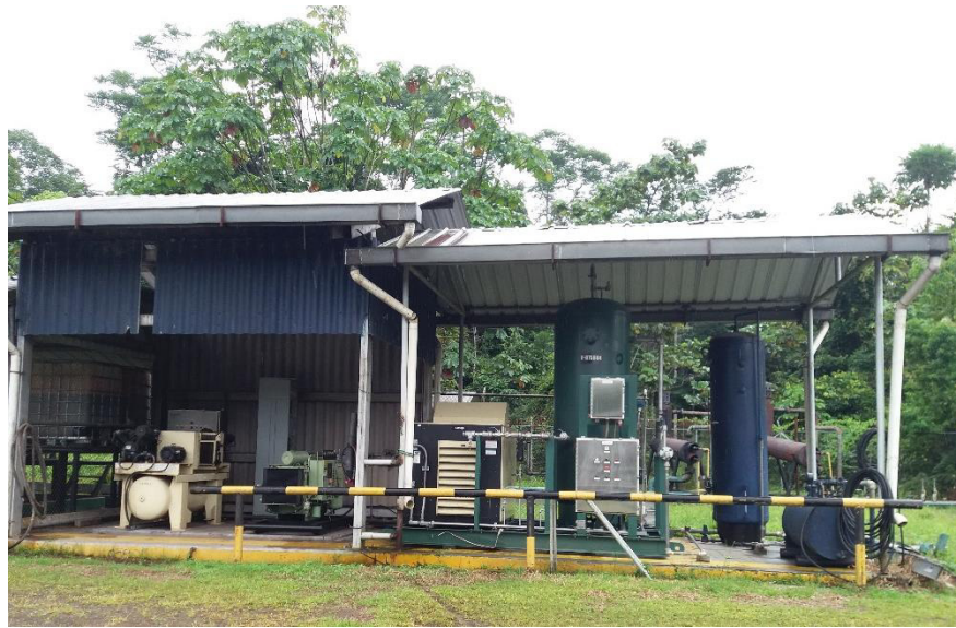
Figura 1.7 Compresores de aire Fuente: (Choca-Quinancela, 2018)
