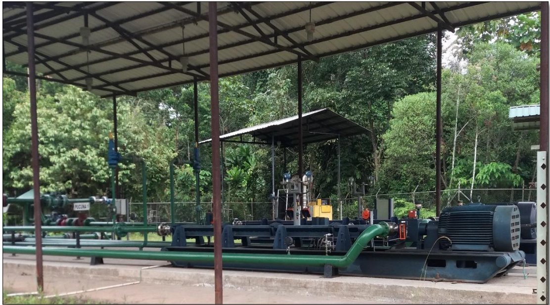
Figura 1.25 Unidades de bombeo horizontal (HPS)
