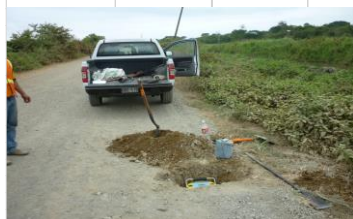
Medición con Geogauge sobre la subrasante.
