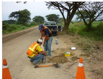
Medición con Geogauge sobre la subrasante.
