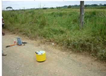
Medición con Geogauge sobre el lastrado.
