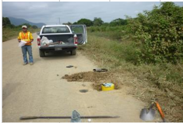
Medición con Geogauge sobre la subrasante.
