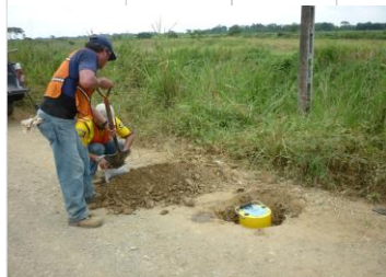
Medición con Geogauge sobre la subrasante.
