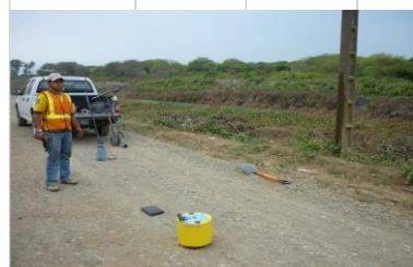
Medición con Geogauge sobre el lastrado.
