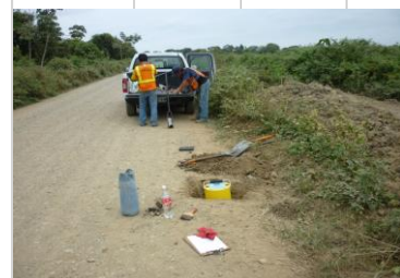
Medición con Geogauge sobre la subrasante.
