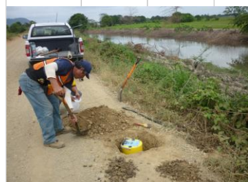
Medición con Geogauge sobre la subrasante.
