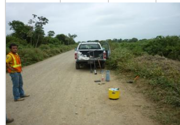
Medición con Geogauge sobre el lastrado.
