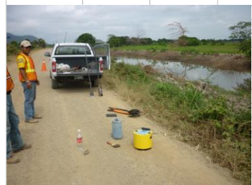
Medición con Geogauge sobre el lastrado.
