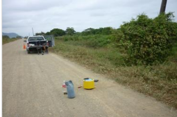
Medición con Geogauge sobre el lastrado.
