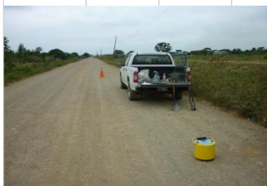
Medición con Geogauge sobre el lastrado.
