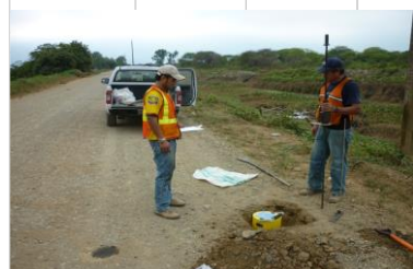
Medición con Geogauge sobre la subrasante.
