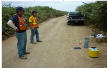
Medición con Geogauge sobre el lastrado.
