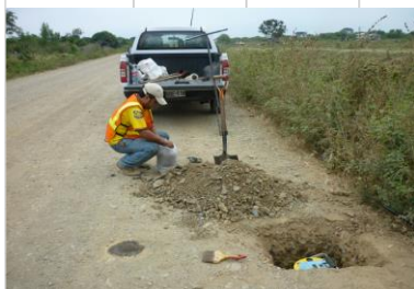
Medición con Geogauge sobre la subrasante.
