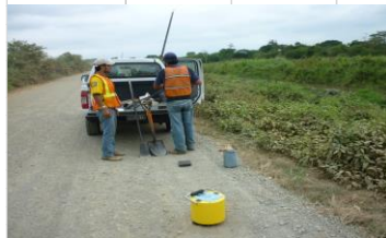
Medición con Geogauge sobre el lastrado.
