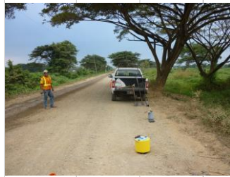
Medición con Geogauge sobre el lastrado.
